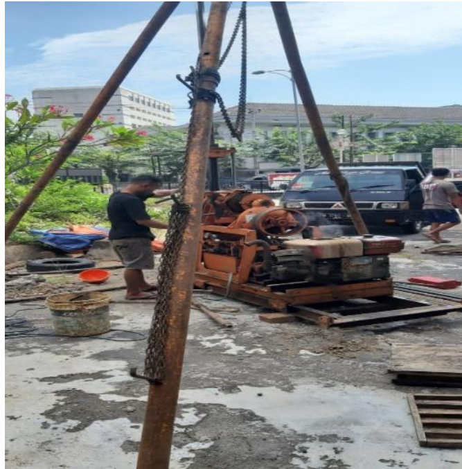
Gambar : Uji Sondir Tanah
