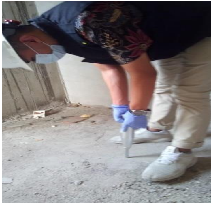
Gambar Pengujian Hammer Pada Pelat Lantai
