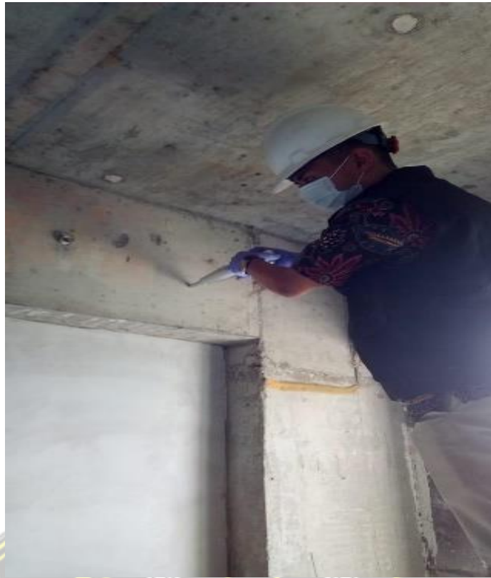
Gambar Pengujian Hammer Pada Balok
