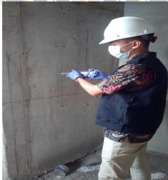
Gambar Pengujian Hammer Pada Kolom
