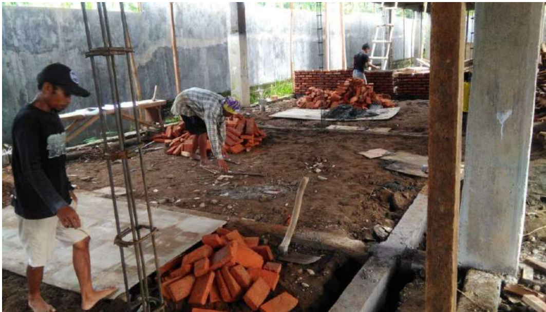
Gambar 1.2. Proses pekerjaan pemasangan batu bata merah di proyek LIK Kota Pekalongan.
