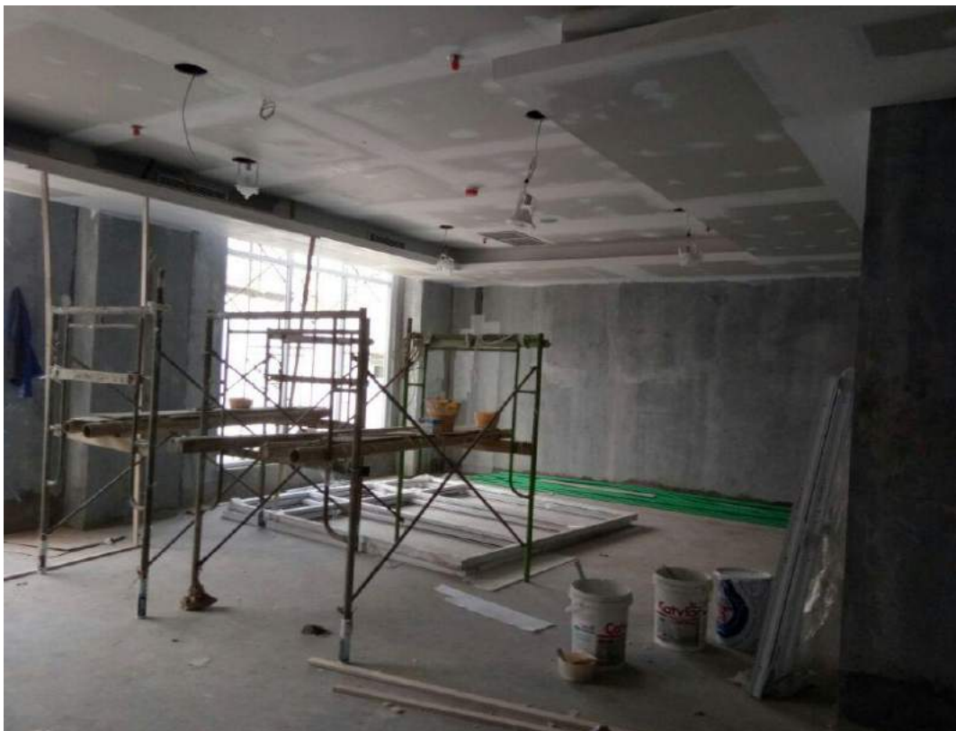
Gambar 1.3. Proses pekerjaan plester aci dan proses persiapan pengecatan dinding di proyek LIK Kota Pekalongan.
