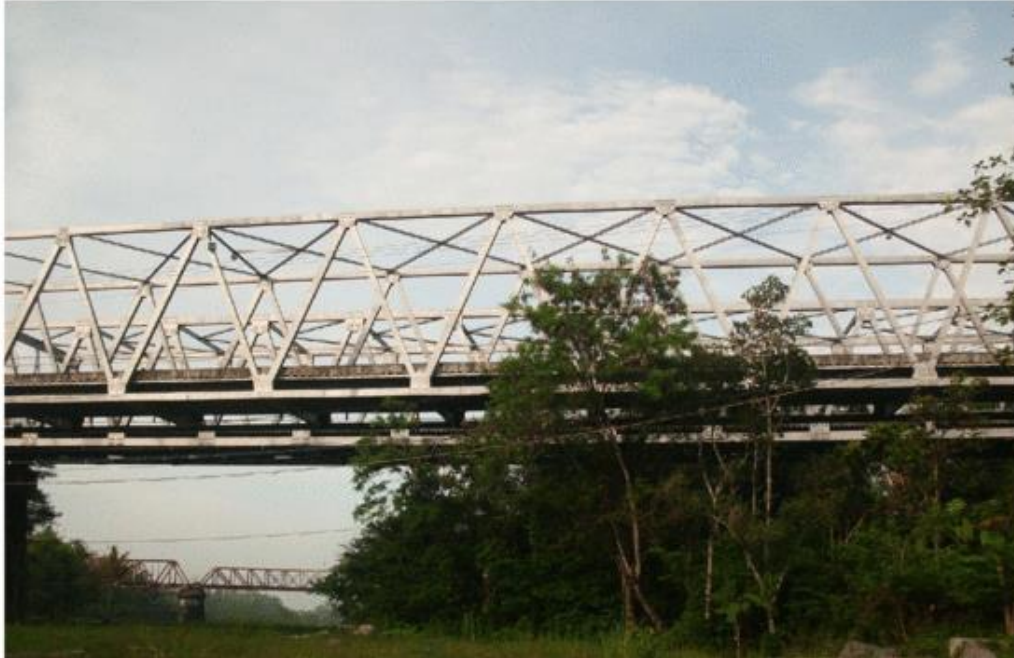
Gambar 1.4 Jembatan Kali Krasak I, Jawa Tengah
