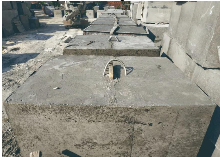
Pelepasan Bekisting Beton Kubus
