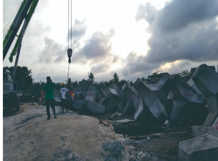
Pelepasan Bekisting Beton A-jack
