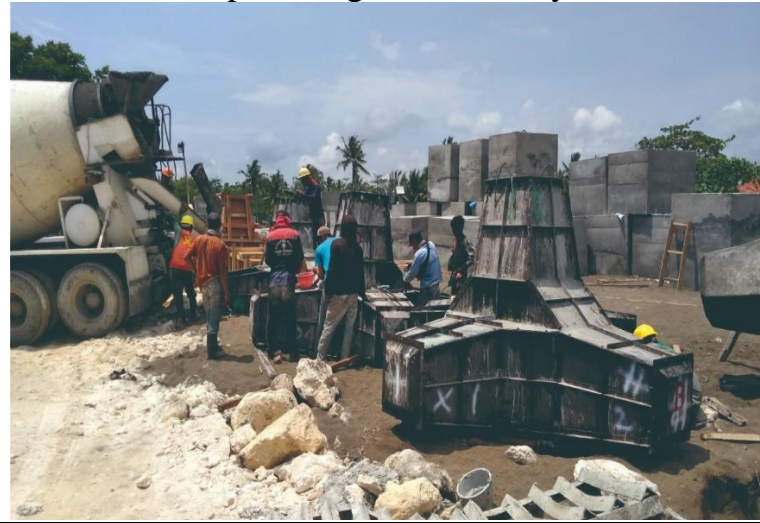
Pelepasan Bekisting Beton A-jack
