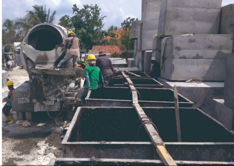
Pelepasan Bekisting Beton Kubus
