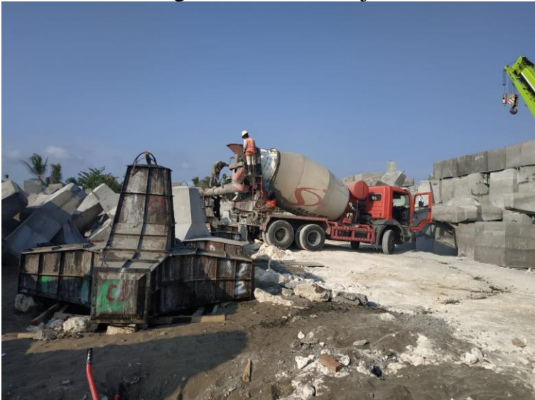
Pengecoran Beton A-jack
