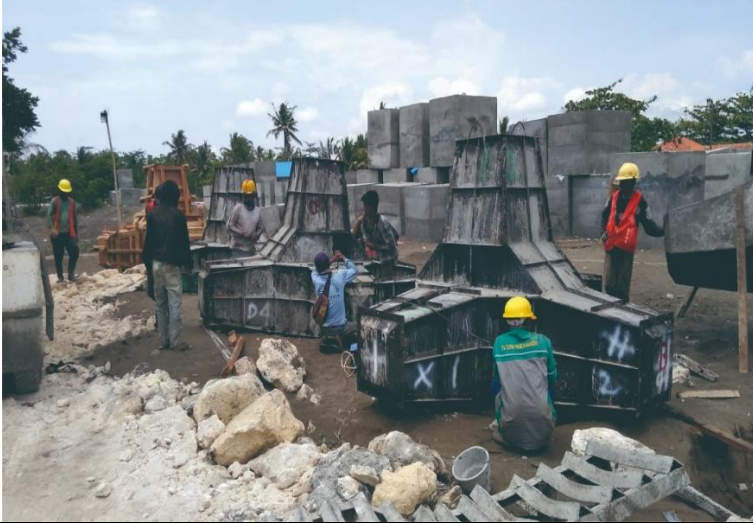
Pengecoran Beton A-jack
