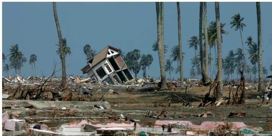
Gambar 1-4. Kondisi bangunan setelah terjadi likuifaksi saat gempa di Donggala-Palu
