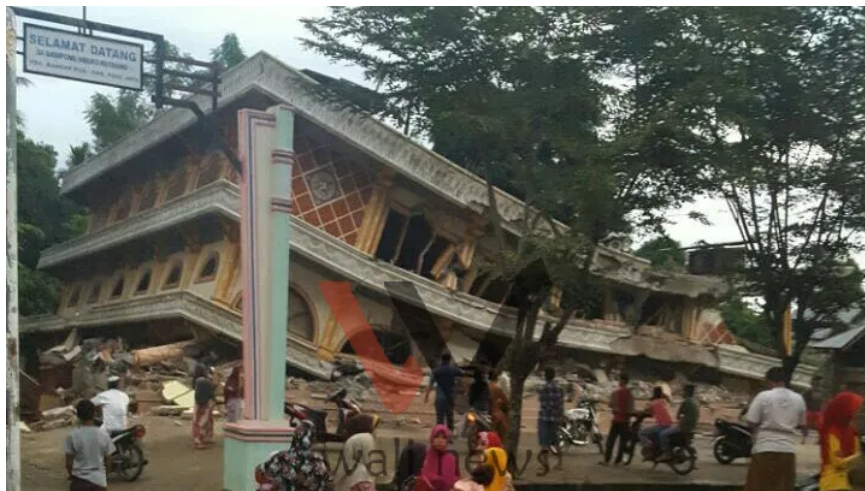
Gambar 1-2. Bangunan bertingkat yang miring karena penurunan pondasi akibat likuifaksi saat gempa bumi di Aceh
