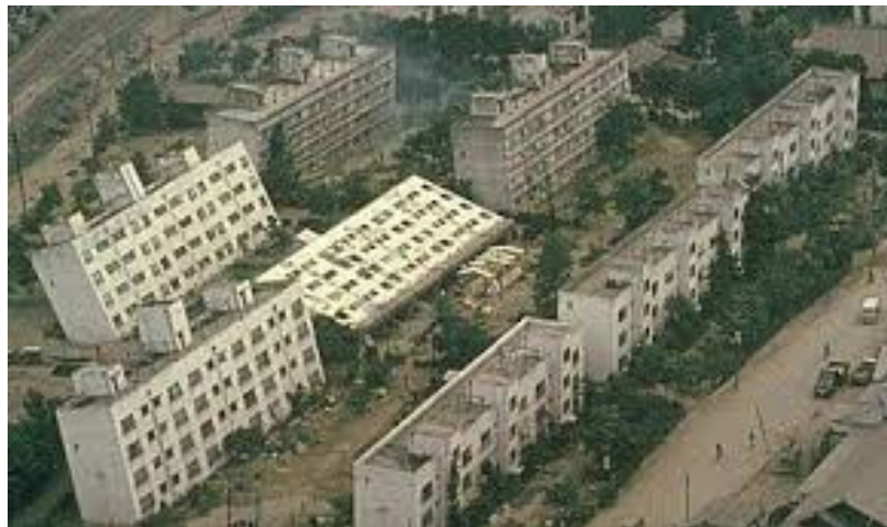
Gambar 1-1. Bangunan bertingkat roboh akibat likuifaksi saat gempa Niigata 1964.
