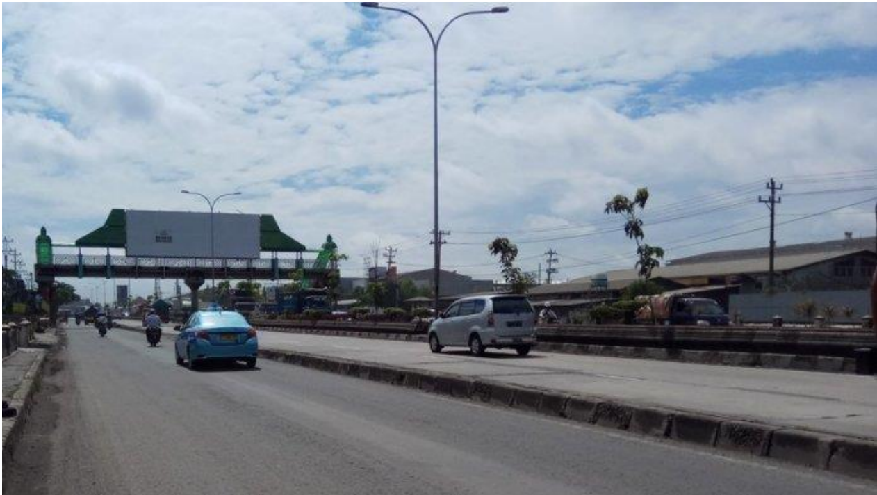
Gambar 1.1 Kondisi Ruas Jalan Kaligawe
