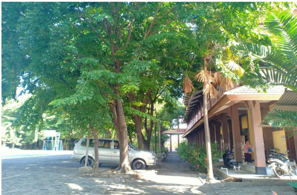
Gambar gedung tampak dari samping
