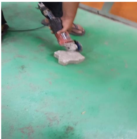
Pemotongan Paving
