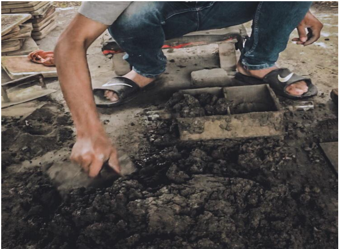
Gambar 9. Pengadukan campuran paving block , siap untuk pencetakan
