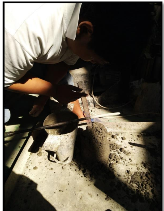
Pengujian nilai slump
