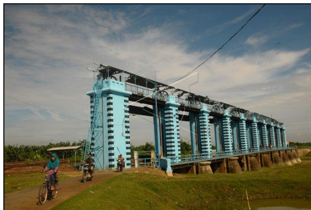
Gambar 1.2 Pintu Banjir Wilalung
