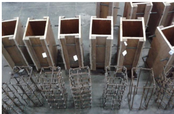
Gambar 3. Bekisting dan konfigurasi tulangan lateral A serta B yang siap dicor
