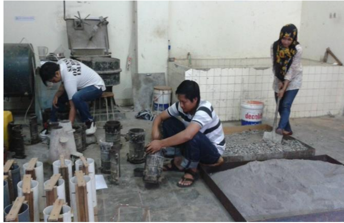
Gambar 4. Persiapan bekisting dan material untuk pengecoran benda uji
