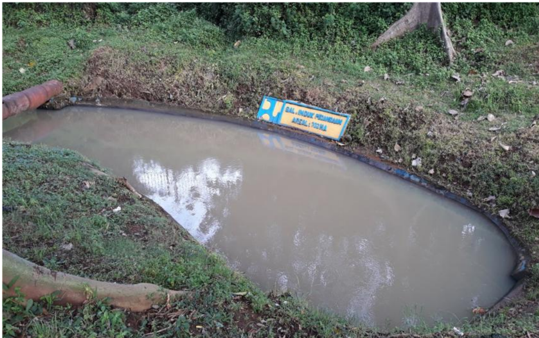
Foto 2. Kolam Intake Saluran Irigasi Sekunder
