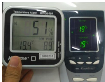
Pengecekan suhu ruangan pada saat setting suhu 19 °c.
