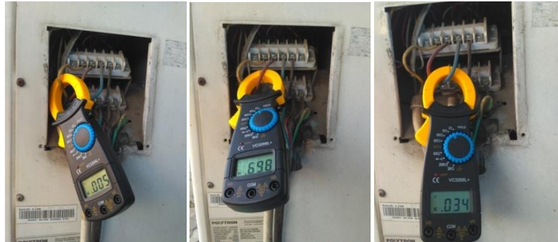
Pengukuran Arus outdoor saat kompresor off pada suhu 25°C.
