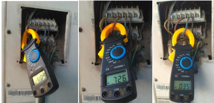
Pengukuran Arus outdoor saat kompresor off pada suhu 22°C.
