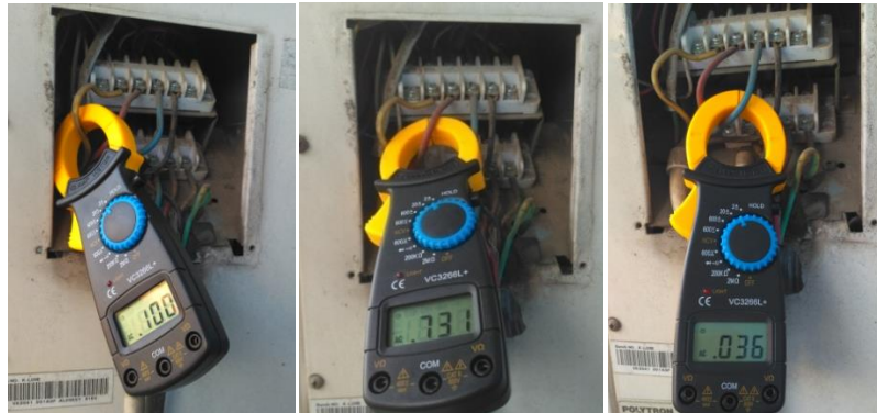
Pengukuran Arus outdoor saat kompresor off pada suhu 19°C.
