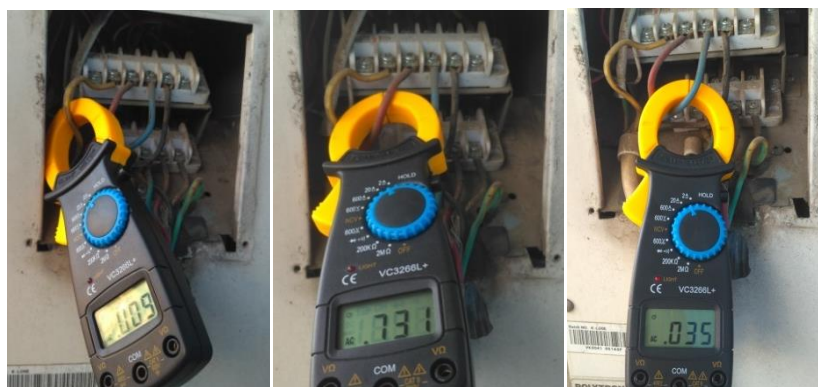
Pengukuran Arus outdoor saat kompresor off pada suhu 21°C.
