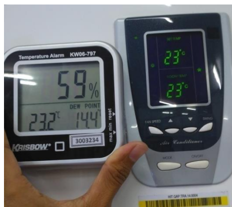
Pengecekan suhu ruangan pada saat setting suhu 23°C.
