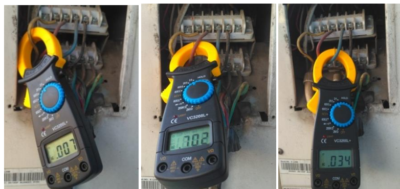
Pengukuran Arus outdoor saat kompresor off pada suhu 24°C.
