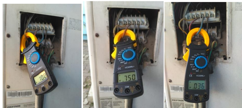
Pengukuran Arus outdoor saat kompresor off pada suhu 18°c.
