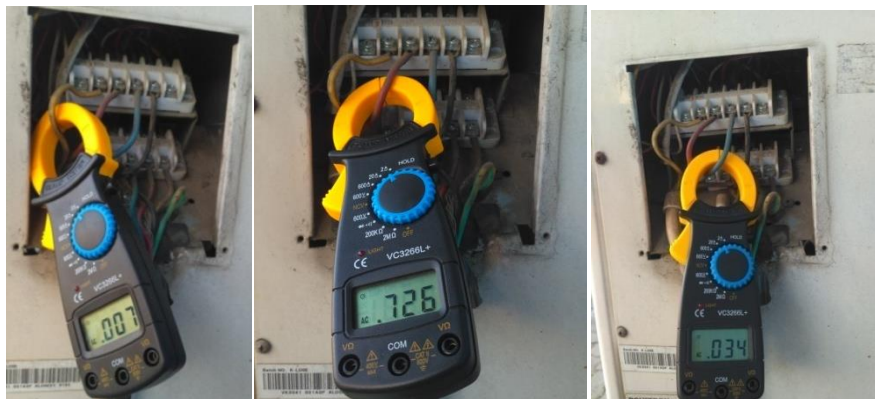
Pengukuran Arus outdoor saat kompresor off pada suhu 23°C.
