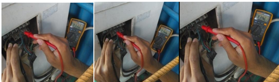
Pengukuran tegangan pada outdoor Air Conditioner saat on .
