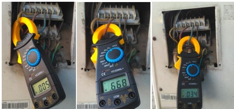
Pengukuran Arus outdoor saat kompresor off pada suhu 26°C.
