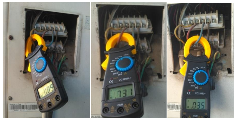
Pengukuran Arus outdoor saat kompresor off pada suhu 20°C.
