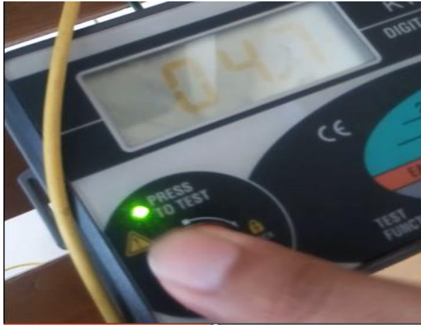
7. Pengukuran Tahanan Pentanahan pada Kantor Kecamatan Cluwak
