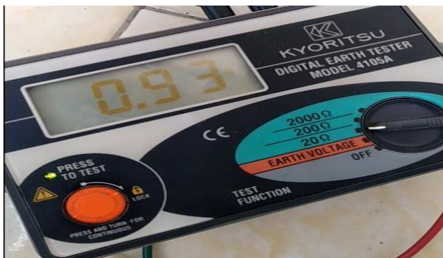
9. Pengukuran Tahanan Pentanahan pada Kantor Kecamatan Jaken
