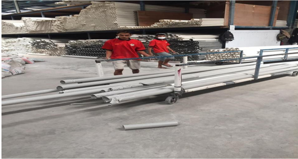
Gambar 4. 44 Pekerja Tidak Menggunakan APD
