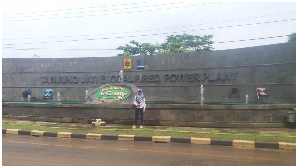
PLTU TANJUNG JATI B UNIT 1 & 2
