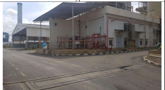
Pertigaan Kembar FGD belakang gypsum bunker
