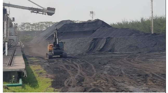
Excavator sedang melakukan compacting
