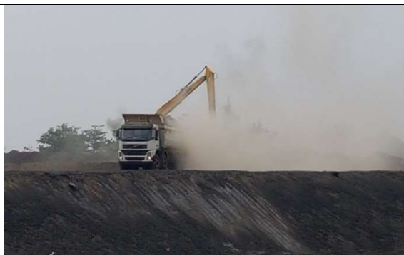
Kondisi perdebusan di ash yard
