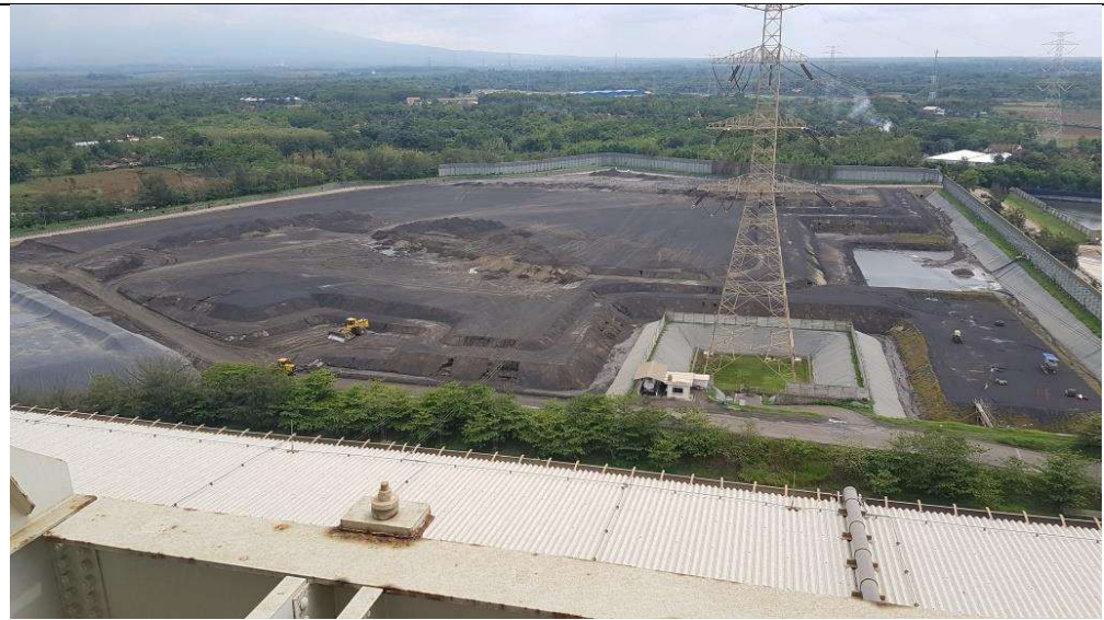
Ash Yard dari boiler lantai 7
