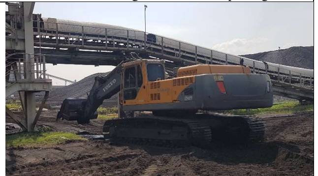
Excavator melintas di bawah conveyor 105
