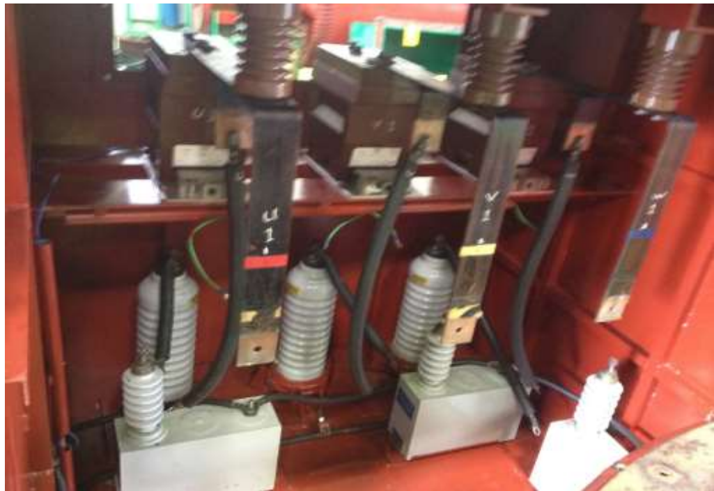
Lampiran 7. Hubung bintang pada terminal box motor TOSHIBA
