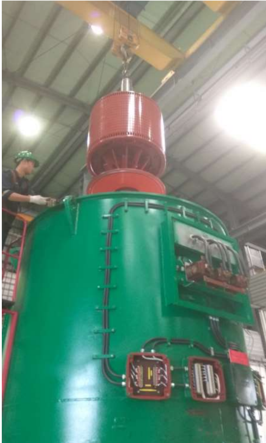
Lampiran 8. Pemasangan Rotor dengan Stator dengan alat bantu overhead crane
