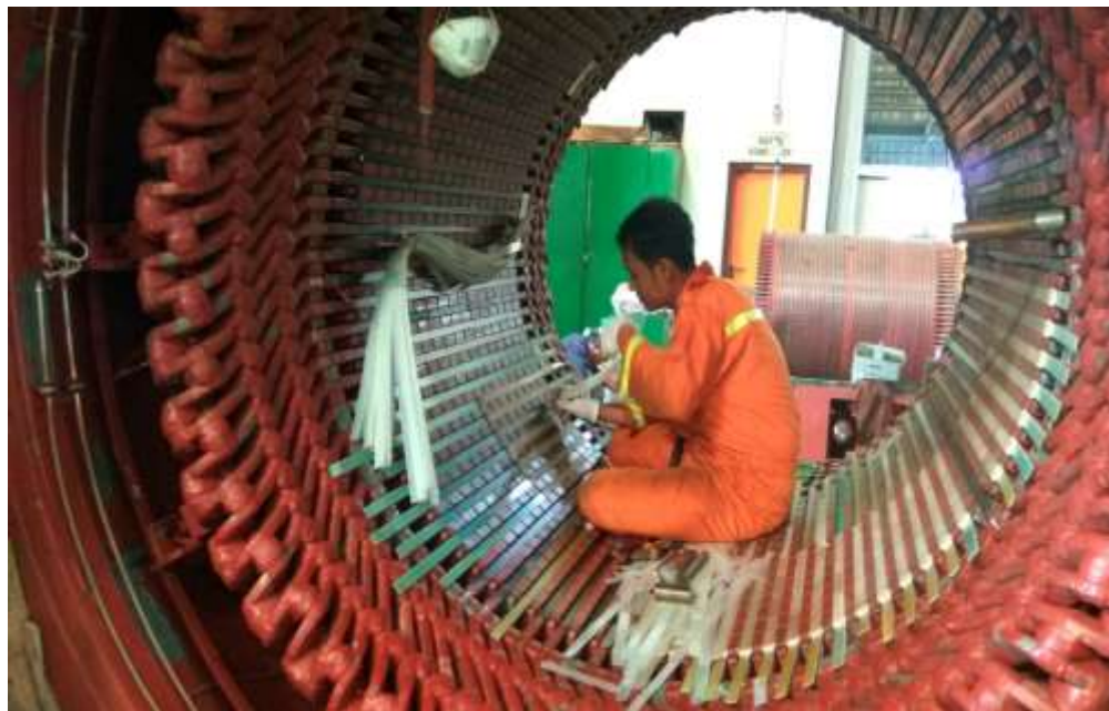
Lampiran 3. Pemasangan Wedges pada bagian slot stator
