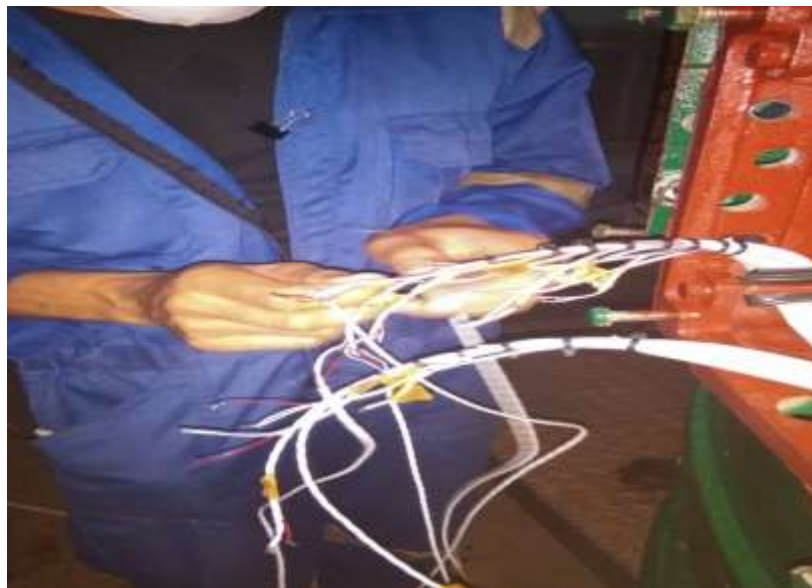
Lampiran 5. Pemasangan kabel RTD pada terminal BOX
