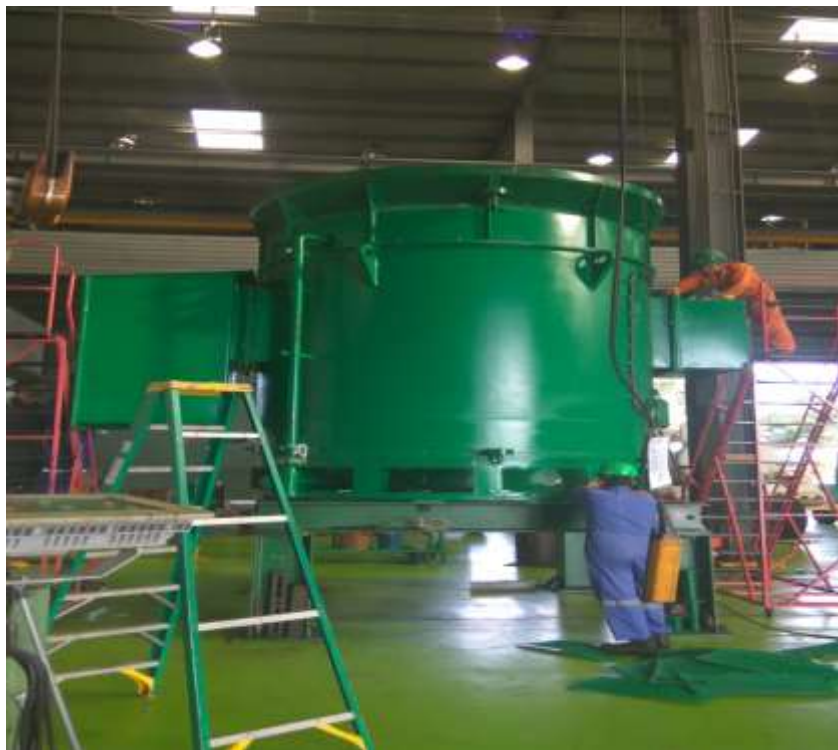
Lampiran 10. Pemasangan terminal Box pada motor TOSHIBA
