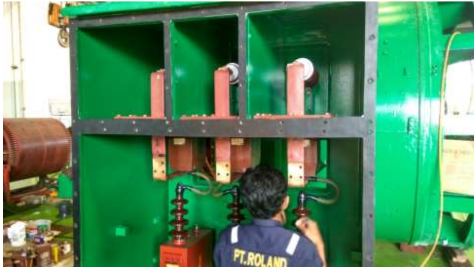
Lampiran 3. Pemasangan CT pada bagian terminal box
