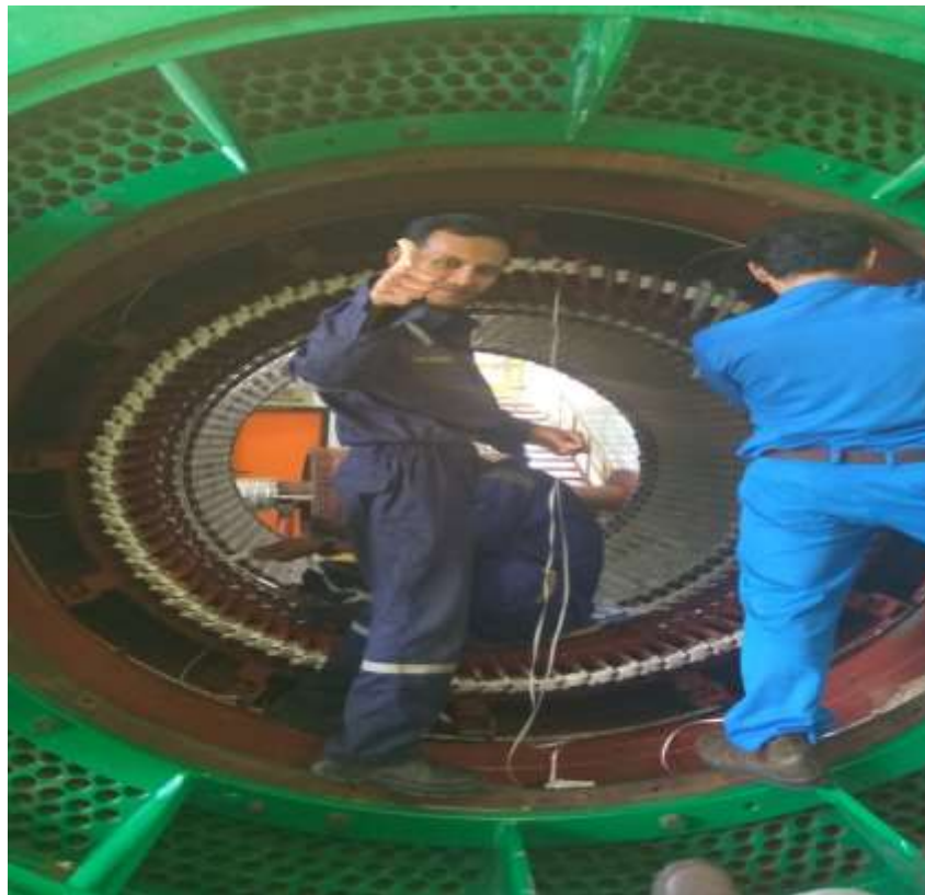
Lampiran 5. Pemasangan kabel RTD pada terminal BOX
