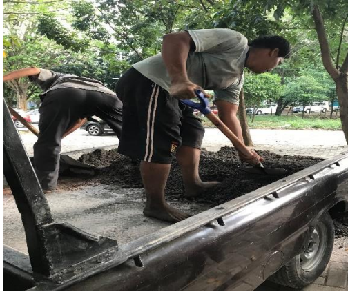
Proses Penurunan Material
