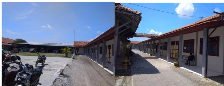
Gambar 3.2 Gambar Gedung C
