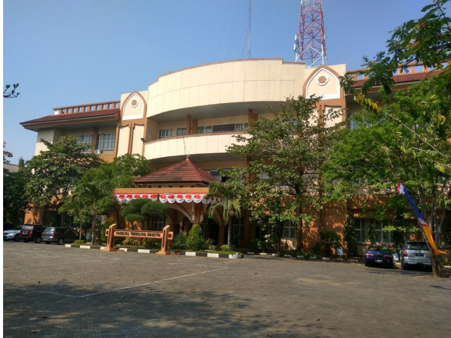
Lampiran 7 Lokasi pengambilan sampel existing pada gedung Fakultas Teknologi Industri UNISSULA
