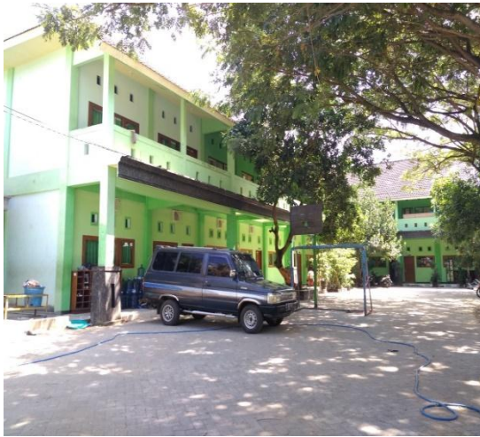
Gedung SMPIT Al – Uswah
